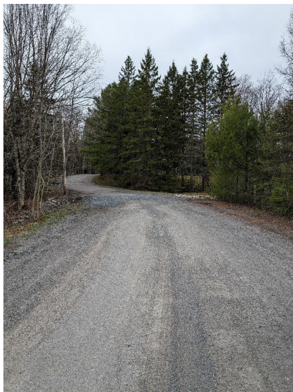
Figure 11 - Chemin de la Paix (dessus du barrage)
