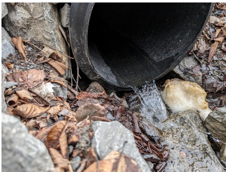
Figure 8 - Débit d'évacuation du barrage en date de l'inspection
