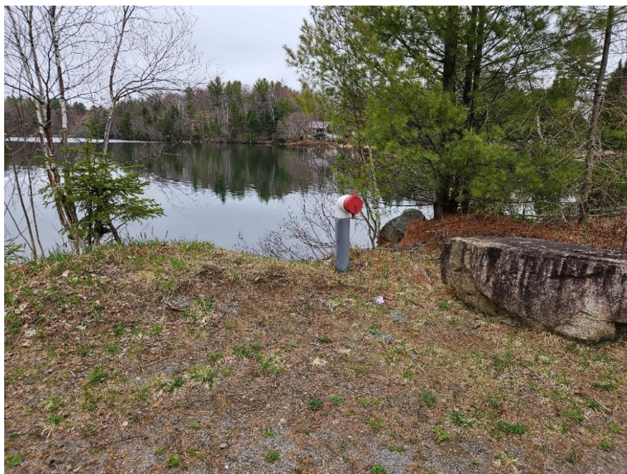
Figure 5 - Borne sèche à l'extrémité gauche du barrage
