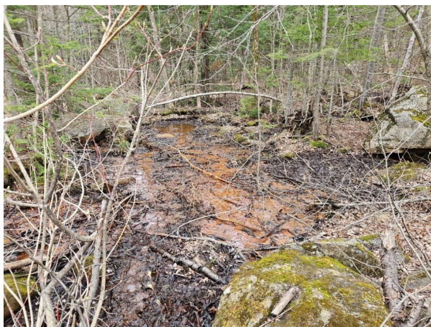
Figure 10 - Zone ferreuse (trace de rouille) en aval du barrage (au sud du Chemin de la Paix)
