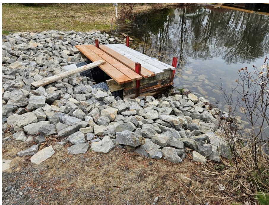
Figure 6 - Seuil de l'appareil d'évacuation en amont (fin de la rive gauche / aucune rive droite)
